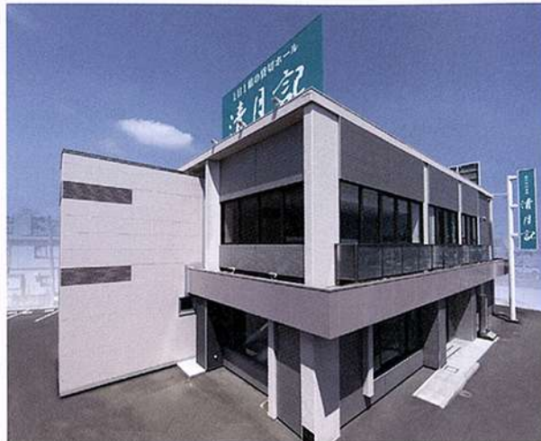
リノベーション前のエントランス位置(写真左側)にエレベータを新設し、エントランスを写真右側に変えた「仙台中田斎場 清月記」
